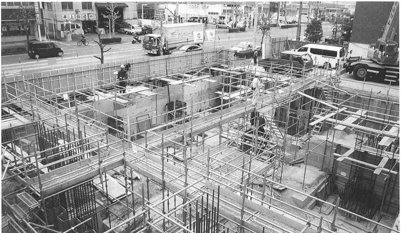
「グランディア宮西 建設現場」
