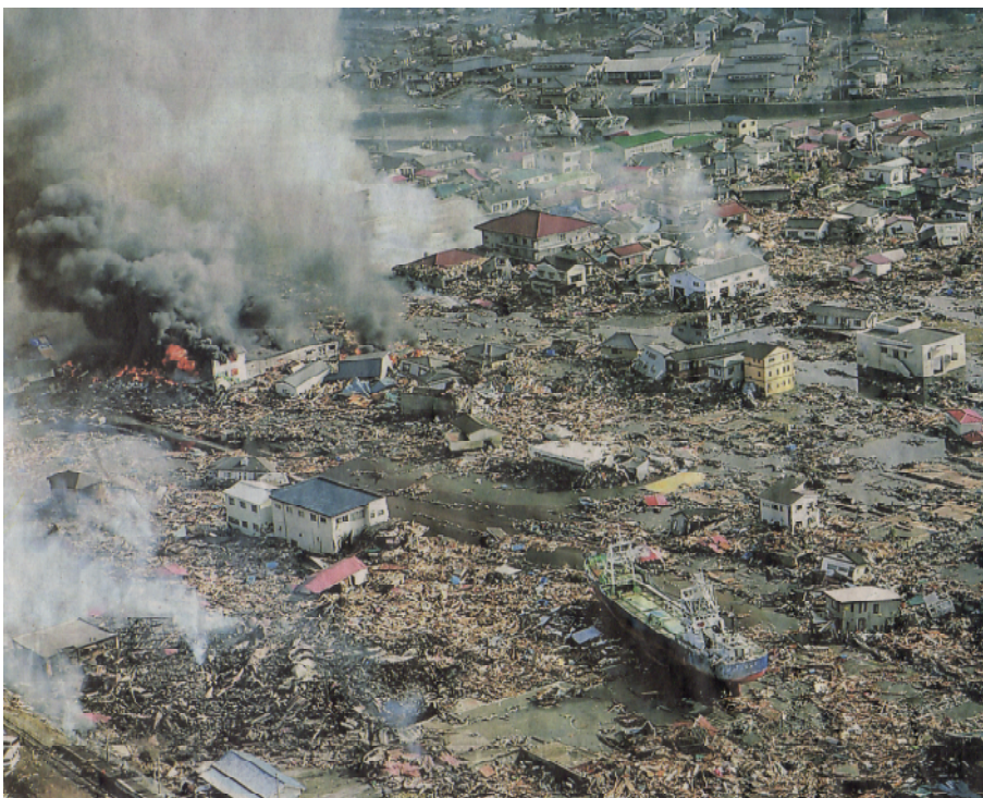
津波で被害を受けた宮城県気仙沼市街地
