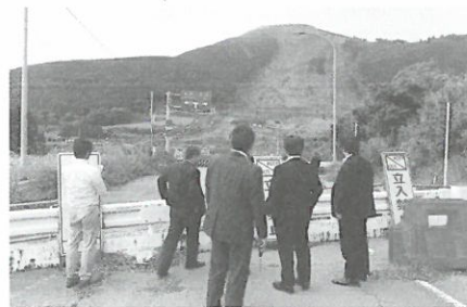
▲阿蘇大橋崩落現場
