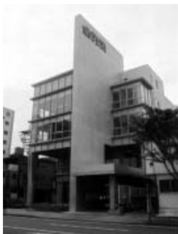
◀ 鉄筋コンクリート4階建ての新会館。下は4月20日の落成式・テープカット。
