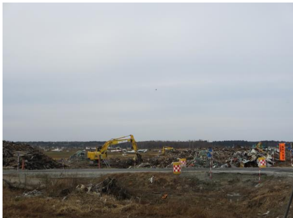
大型重機で瓦礫処理が今も行われており、 選別処理後は別の場所に運ばれる
