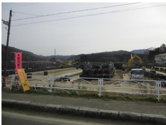
飯舘村除染作業現場
