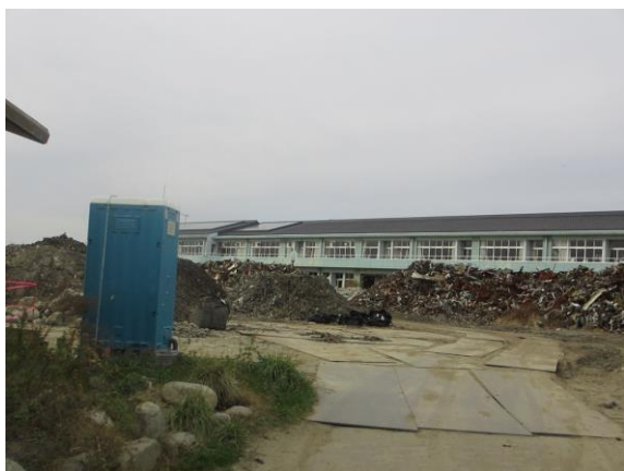
津波の被害にあった請戸小学校
