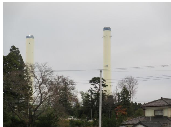
国道 6 号線を南下、双葉郡広野町にある東京電力広野火力発電所の煙突
