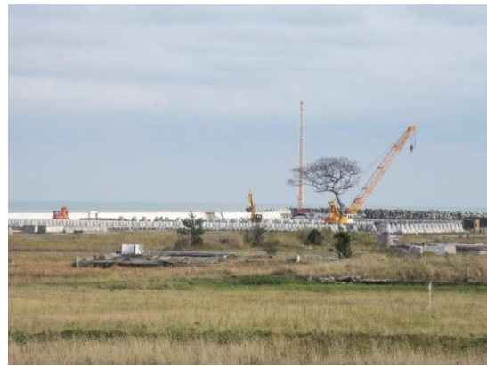
浪江町請戸地区の堤防工事現場
