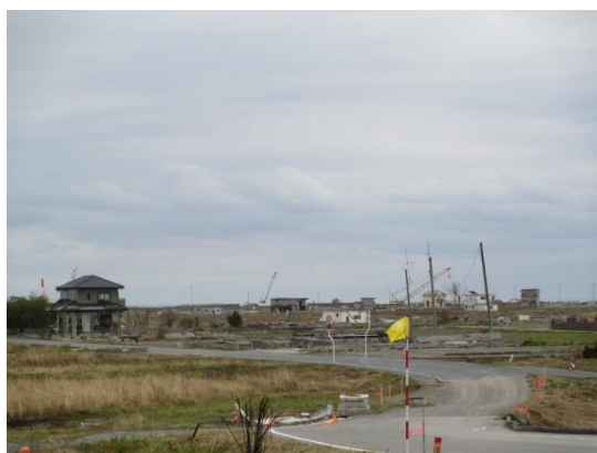
津波被害のあった浪江町住宅地（漁船や自 家用車が処理されていた）
