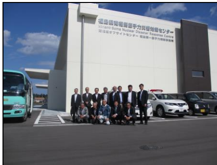
南相馬オフサイトセンター(緊急事態応急対策等拠点施設)
