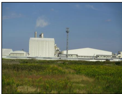
請戸地区にある瓦礫処理施設
