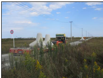
堤防工事のため資材を搬送するトレーラー
