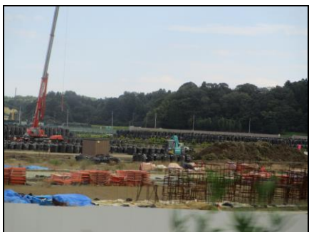
相馬郡飯舘村の除染現場(車窓から)
