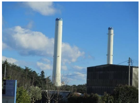
東京電力広野火力発電所
