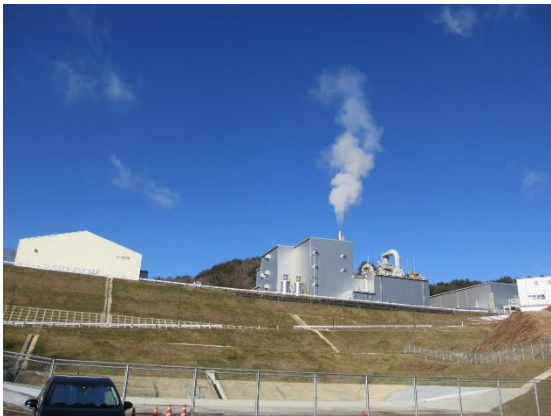
一般廃棄物(片付けごみ、家屋解体・除染など)・産業廃棄物(汚泥、木くず、廃油、廃プラスチック類)中間処理施設(飯舘村長泥地区・焼却施設)
