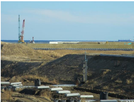
双葉郡浪江町請戸地区・堤防工事現場
