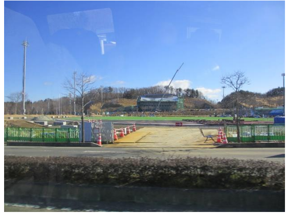
来年4月開校に向けて建設されている飯舘村の小学校建設現場
