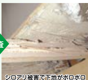
シロアリ被害で下地がボロボロ
