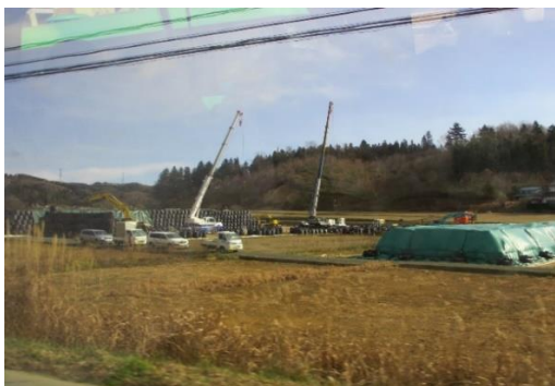
相馬郡飯舘村の除染作業現場(除染作業で除去した土を入れたフレコンバック袋)②
